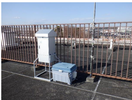
上北台市民センター 屋上
