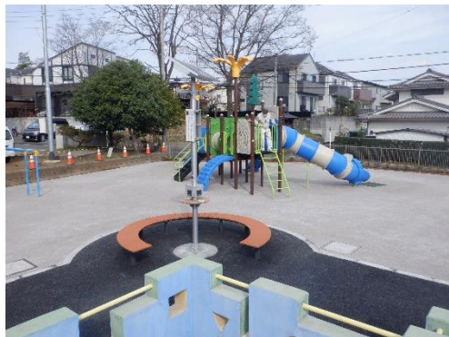
高木公園 改修工事
