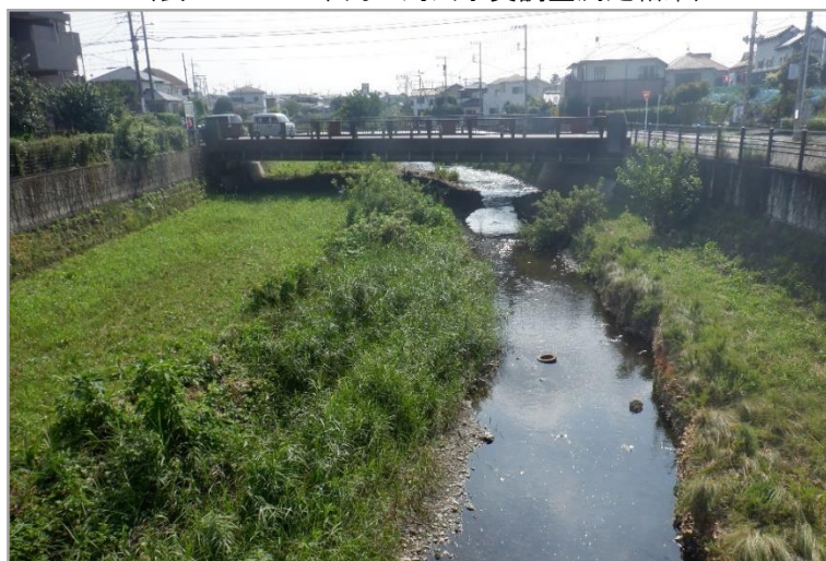
空堀川 清水橋付近
