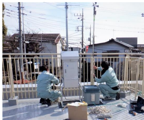
狭山公民館 屋上
