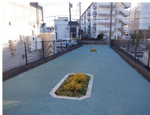
立野南緑地遮熱性アスファルト舗装
