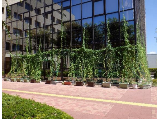
東大和市役所本庁舎のグリーンカーテン
