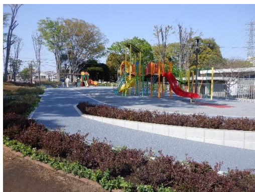
上仲原公園遮熱性アスファルト舗装
