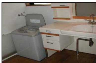
(洗面所) 車椅子対応洗濯機置き部分 の床上げ・洗面化粧台・レ バーハンドル水洗
