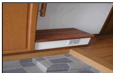
(玄関) 上がりかまち部分の式台 手すり・ベンチ・足元灯
