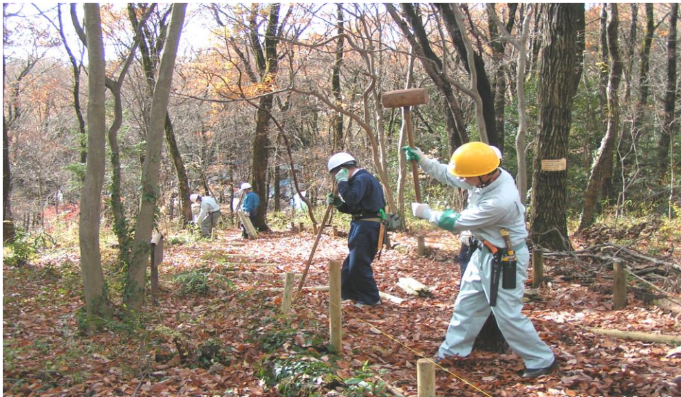
杭打ち作業(狭山緑地雑木林の会)
