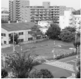
総合福祉センター建設予定地
