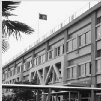
耐震化済みの小学校
