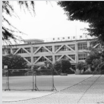
耐震化済みの中学校
