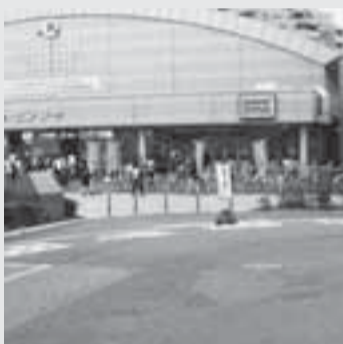
歩道段差を改修した東大和市駅前
