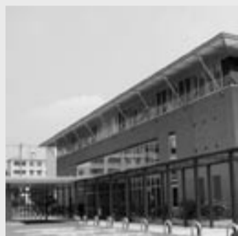
武蔵村山市民総合センター
