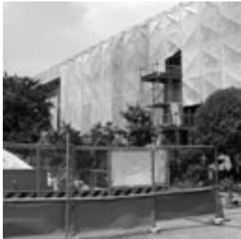
耐震工事中の二中学校舎
