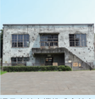
旧日立航空機株式会社変電所
