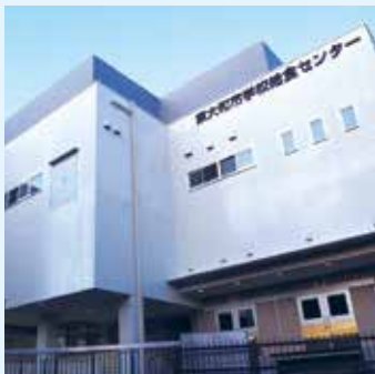
東大和市学校給食センター
