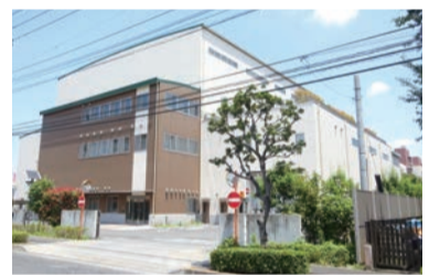
資源物中間処理施設 (エコプラザ スリーハーモニー)
