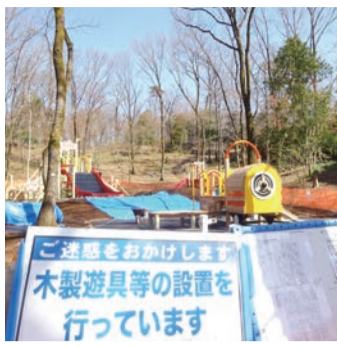
遊具の更新工事(狭山緑地)
