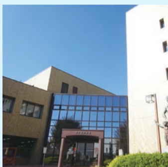
東大和市役所
