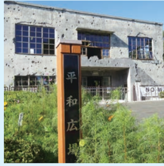
旧日立航空機株式会社変電所
