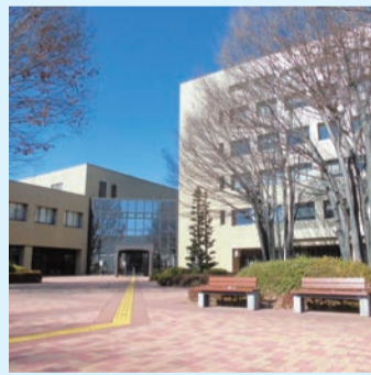
東大和市役所
