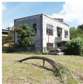
旧日立航空機株式会社変電所
