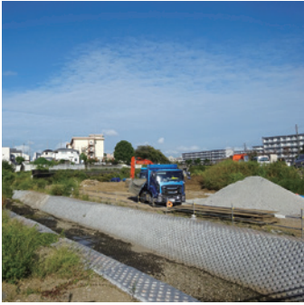
空堀川の工事
