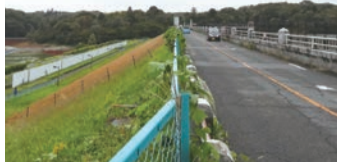
村山貯水池(多摩湖)上堰堤
