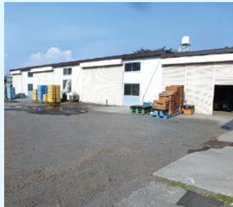
東大和市暫定リサイクル施設
