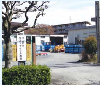
東大和市暫定リサイクル施設
