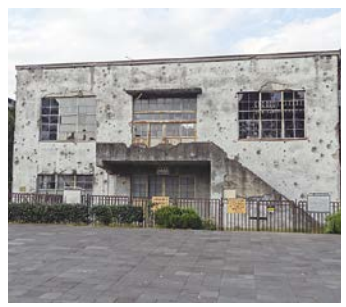
旧日立航空機株式会社変電所
