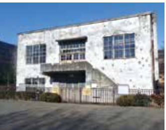
旧日立航空機株式会社変電所
