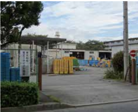
東大和市暫定リサイクル施設
