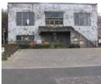
旧日立航空機株式会社 変電所
