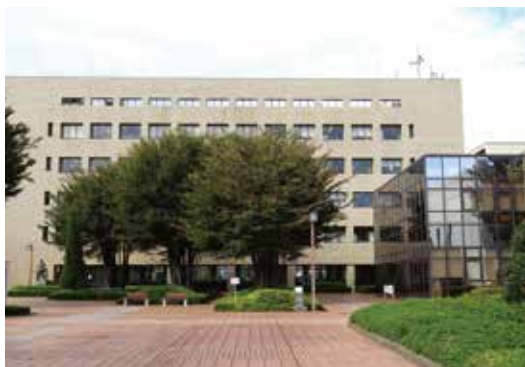
東大和市役所
