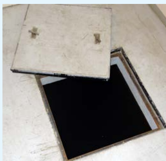
東大和市立郷土博物館の雨水貯留槽
