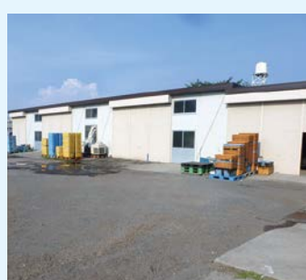
東大和市暫定リサイクル施設
