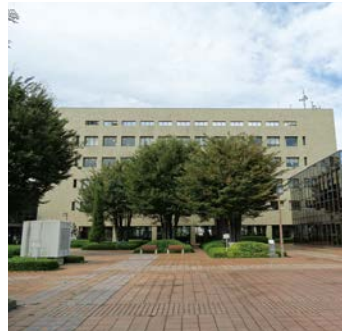
東大和市役所
