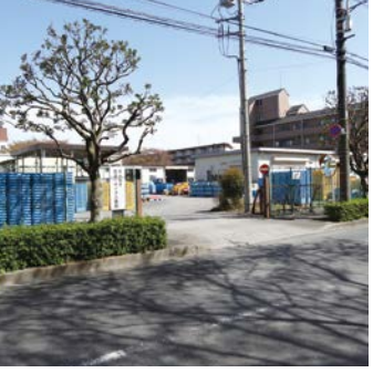
東大和市暫定リサイクル施設
