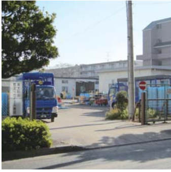
東大和市暫定リサイクル施設
