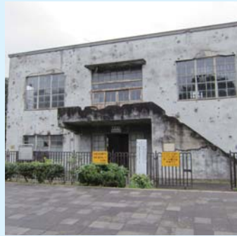
旧日立航空機株式会社変電所
