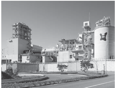
エコセメント施設
