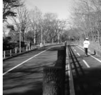
貯水池周囲道路
