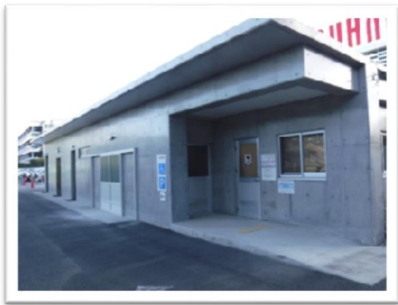
桜が丘市民広場管理棟（入口側）
