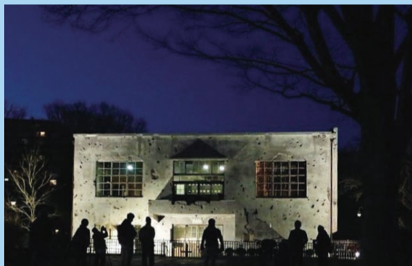
旧日立航空機株式会社変電所のライトアップ
