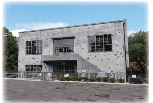
旧日立航空機株式会社変電所
